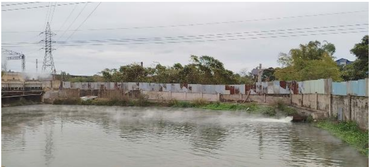
Hình 3.7: Hồ chứa nước làm mát tuần hoàn
