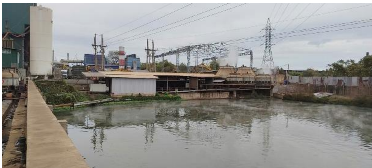
Hình 3.8: Khu trạm bơm nước làm mát lò trung tần
