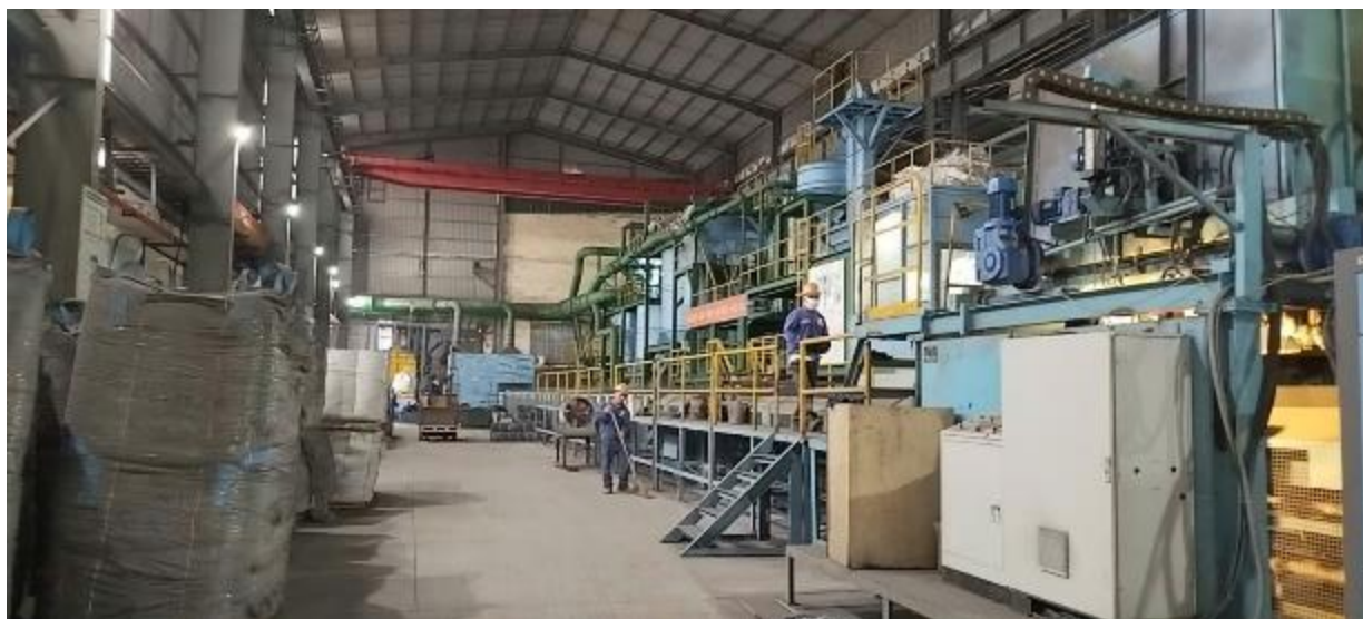
Đường ống hút bụi máy làm khuôn cát tươi
